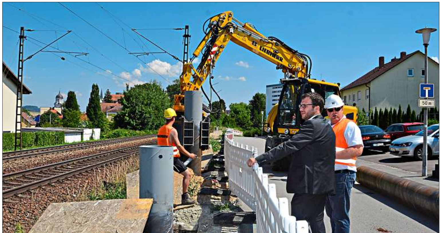
Für die Aluwände am Warbachweg kann der Bautrup von der Straße aus arbeiten. Gegenüber muss das von der Schiene aus erfolgen. Das dürfte frühestens 2019 möglich sein, hat Bürgermeister Florian Gams vor Ort erfahren. – Foto: Rucker
